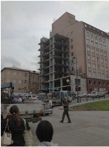
▲終わらぬ工事
