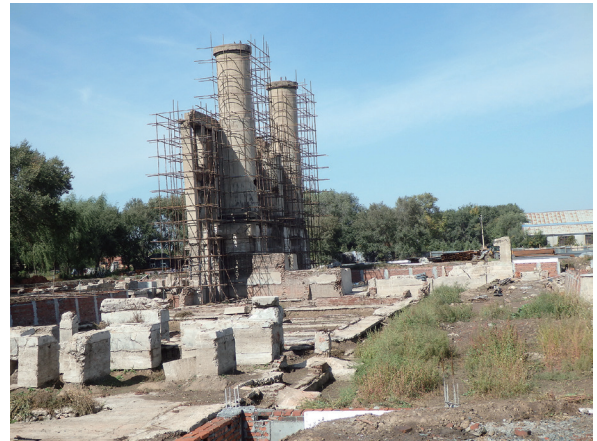
旧731部隊本部・ボイラー室遺構(石田撮影)
