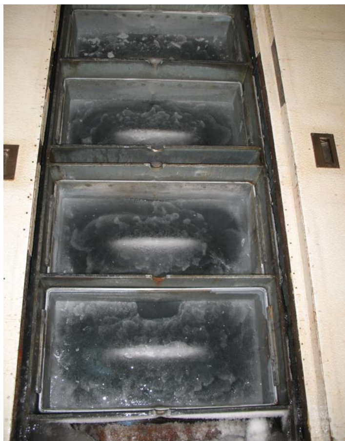
■(写真右上) 製氷室内全景。板の下には氷缶がずらっと並んでいる。(写真右下) 板をめくって氷缶を上から見たところ。縦 26cm、横 56cm で、深さは 1m ある。これは水産用で芯が太い。(写真上) 芯の細い陸上用。(いずれも株式会社市場製氷にて)
