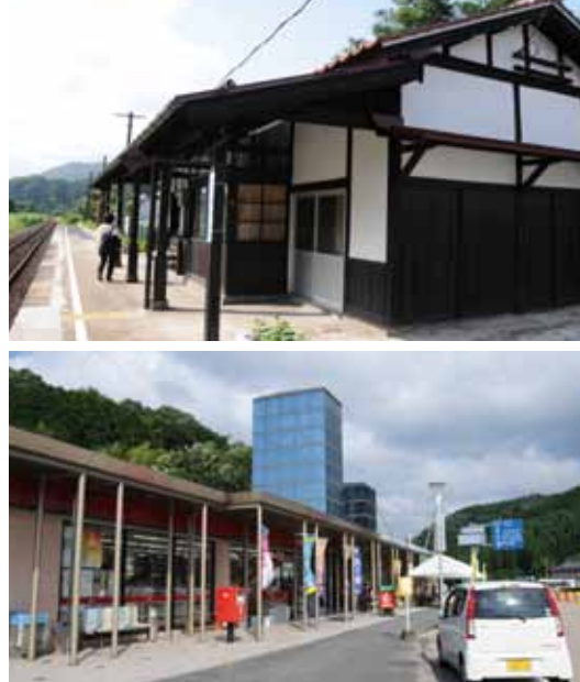
■(上段) 出雲八代駅。駅舎とホーム。(下段) 出雲三成駅。駅の上に見えるのは珍しい形をした吹き抜け。
