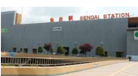
■みちのくの玄関、JR仙台駅。シートで覆われている。
